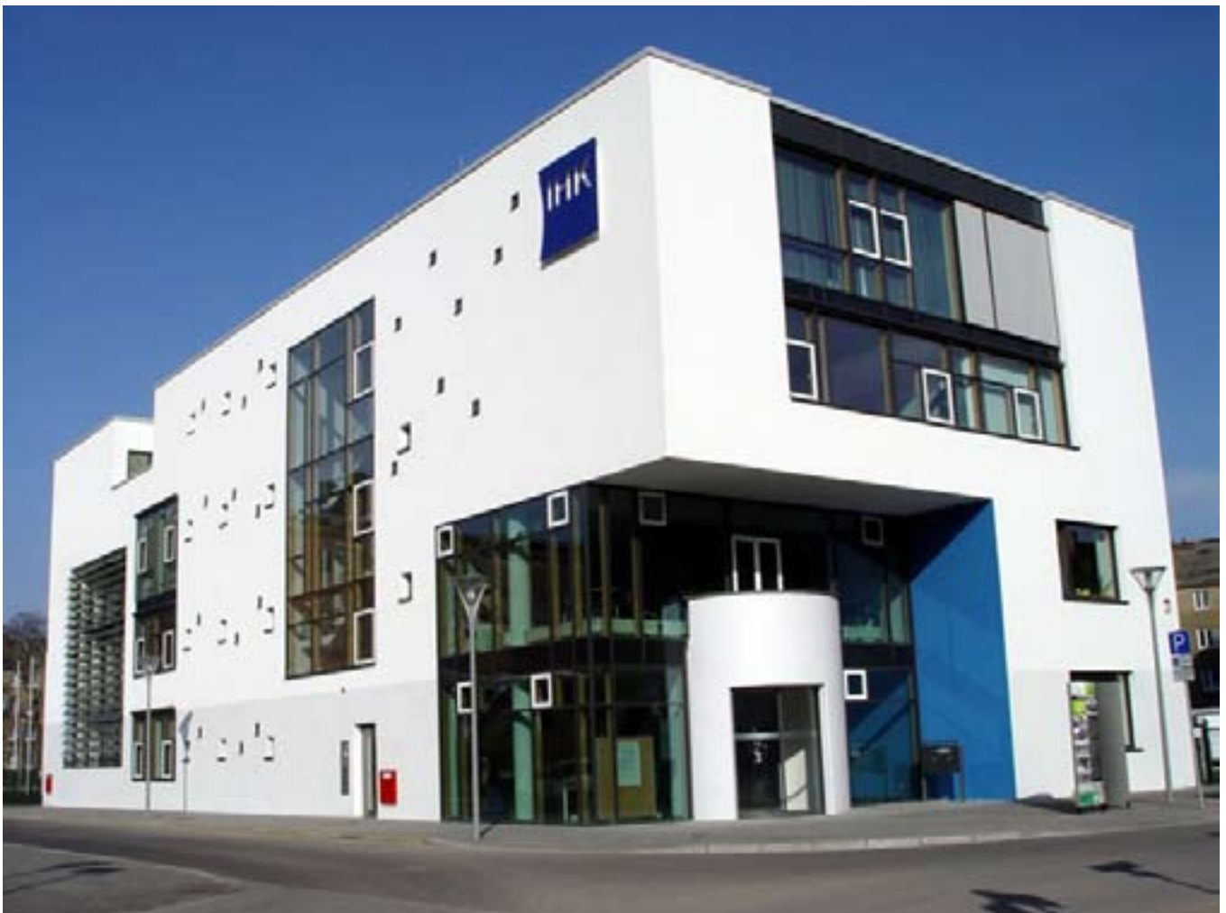
Gebäude der IHK Halle-Dessau in Dessau
